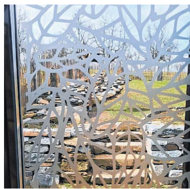
Die neuen Fensterfolien verhindern, dass Vögel gegen die Fenster der Herberge fliegen.
